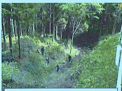
高洞自治公民館 旭の又線高洞地区環境整備
