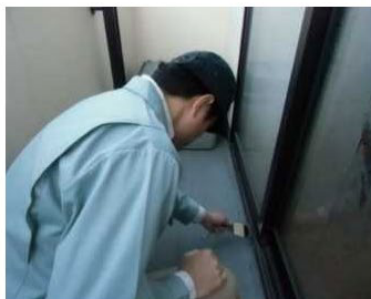
「外部（バルコニー）」調査の様子
