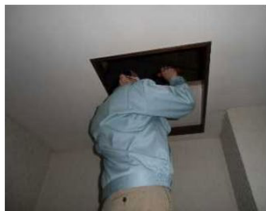
「小屋組・梁」調査の様子
