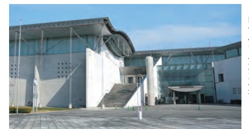
女子トイレを洋式化した総合体育館(本館)
