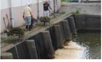
スクリーンの除塵作業
