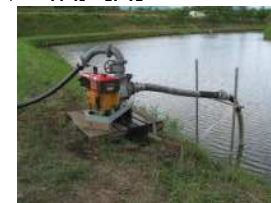
応急ポンプの設置・運転
