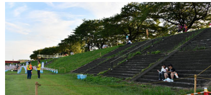
イベント時、既存の階段護岸は避難路として確保するため、観覧席にはできない
