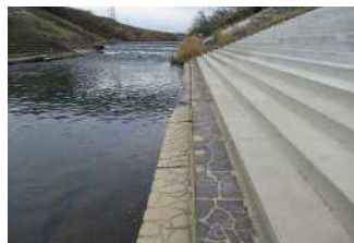
上段のステップはコンクリートで改修。下段のステップは湾曲している（左岸）
