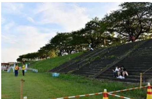
既設の階段護岸
