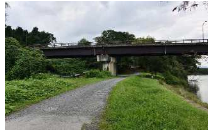
管理用通路の未舗装の坂路
