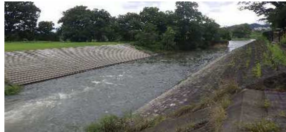
水辺プラザの階段護岸
