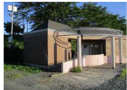
イギリス海岸付近さわやかトイレ
