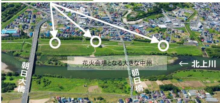
白丸：既存の階段護岸の位置
