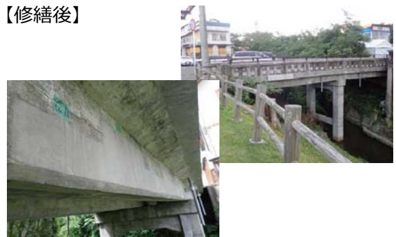
【対策内容】断面修復
