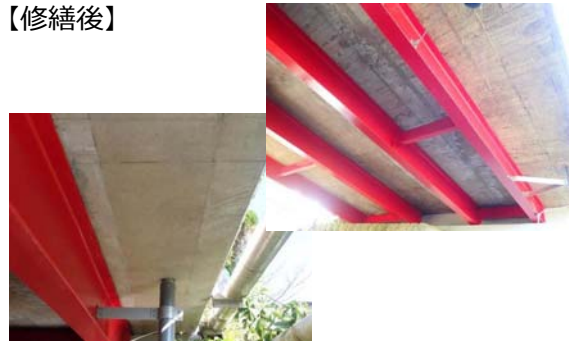
【対策内容】床版部分打換え/塗替塗装
