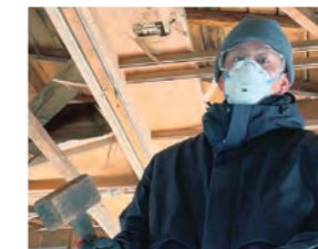
▲古民家のリノベーションに取り掛かりました
